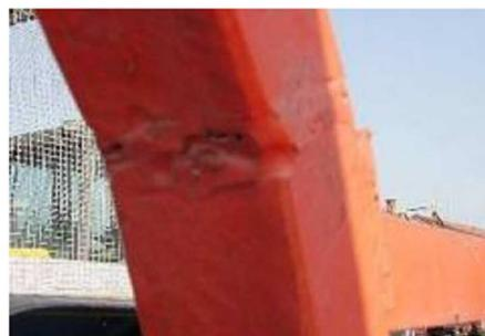
Fig. 8. Esempio di ammassatura di tubolare a sezione non circolare con depressioni della superficie che interessano anche gli spigoli e assottigliamento della sezione resistente utile
