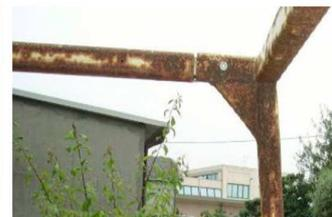
Fig. 2. Esempio di corrosione localizzata (a sinistra) e diffusa (a destra), ma comunque di tipo superficiale, con una riduzione della sezione resistente inferiore al 20%
