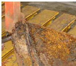
Fig. 3. Esempio di corrosione avanzata, con una riduzione della sezione resistente nettamente superiore al 20%, ovvero corrosione passante (in questo caso, 3 dei 4 lati del tubo quadrato visibile nella parte sinistra dell'immagine, in basso, sono completamente assenti)
